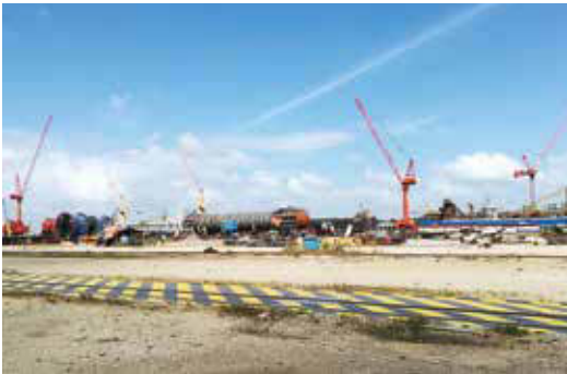
► 中东某地区建筑工地拖挂车临时电源解决方案
